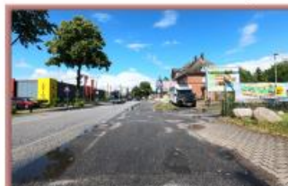
Fehlende Abgrenzung des Wegs und schlechte Oberfläch (Abnauer St.)
